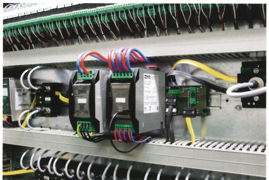
Bild 3 | Das USV-Modul Emparro Accucontrol schaltet bei einem Netzausfall unterbrechungsfrei auf Batteriebetrieb um und vermeidet Maschinenstillstände.
