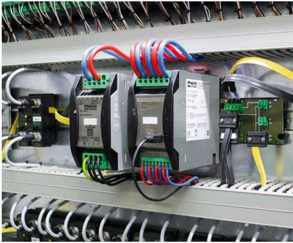
**Nicht vieles in Anlagen und Maschinen ist ärgerlicher (und teurer) als ein ungeplanter Stillstand. Das USV-Modul Emparro ACCUcontrol von Murrelektronik, das das leistungsstarke Emparro-Stromversorgungssystem ergänzt, hält Maschinen am Leben, indem es bei Netzausfällen unterbrechungsfrei auf Batteriebetrieb umstellt. Die Investition in ein USV-System amortisiert sich oft schon beim ersten vermiedenen Stillstand.**
