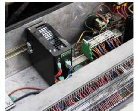
MB Cap zur Pufferung von Spannungsausfällen
